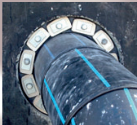
Rurociąg tłoczny fi 315.
